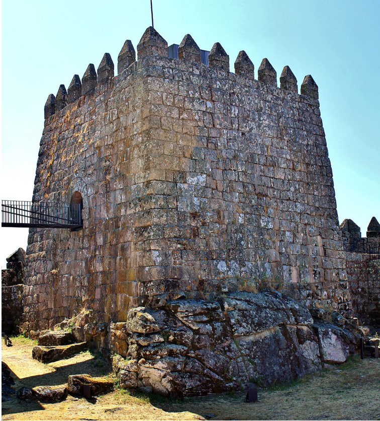
Figura 2. Torre troncocónica del castillo de Trancoso. Según Barroca (2008-2009, p. 209), es el único resto original del siglo X. Fotografía propia, julio 2025.
