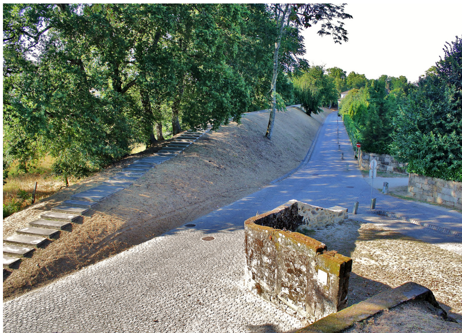
Figura 1. «Cava de Viriato» (Viseo). Talud y entrada occidental (rua Heróis Lusitanos). Fotografía propia, julio 2024.
